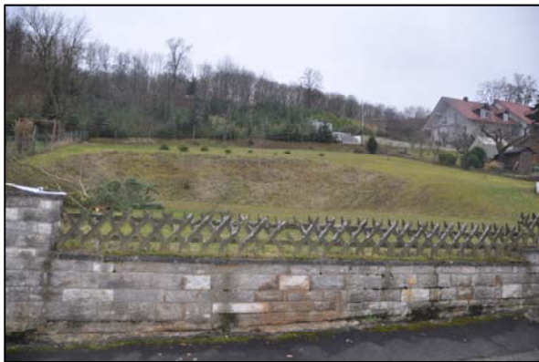
Abbildung 4: Ansicht von der Siedlungsstraße (Norden)
